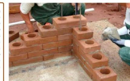
O meio tijolo pode ser cortado em obra com auxílio de disco ou serrote. Posicione-los nos locais indicados.
